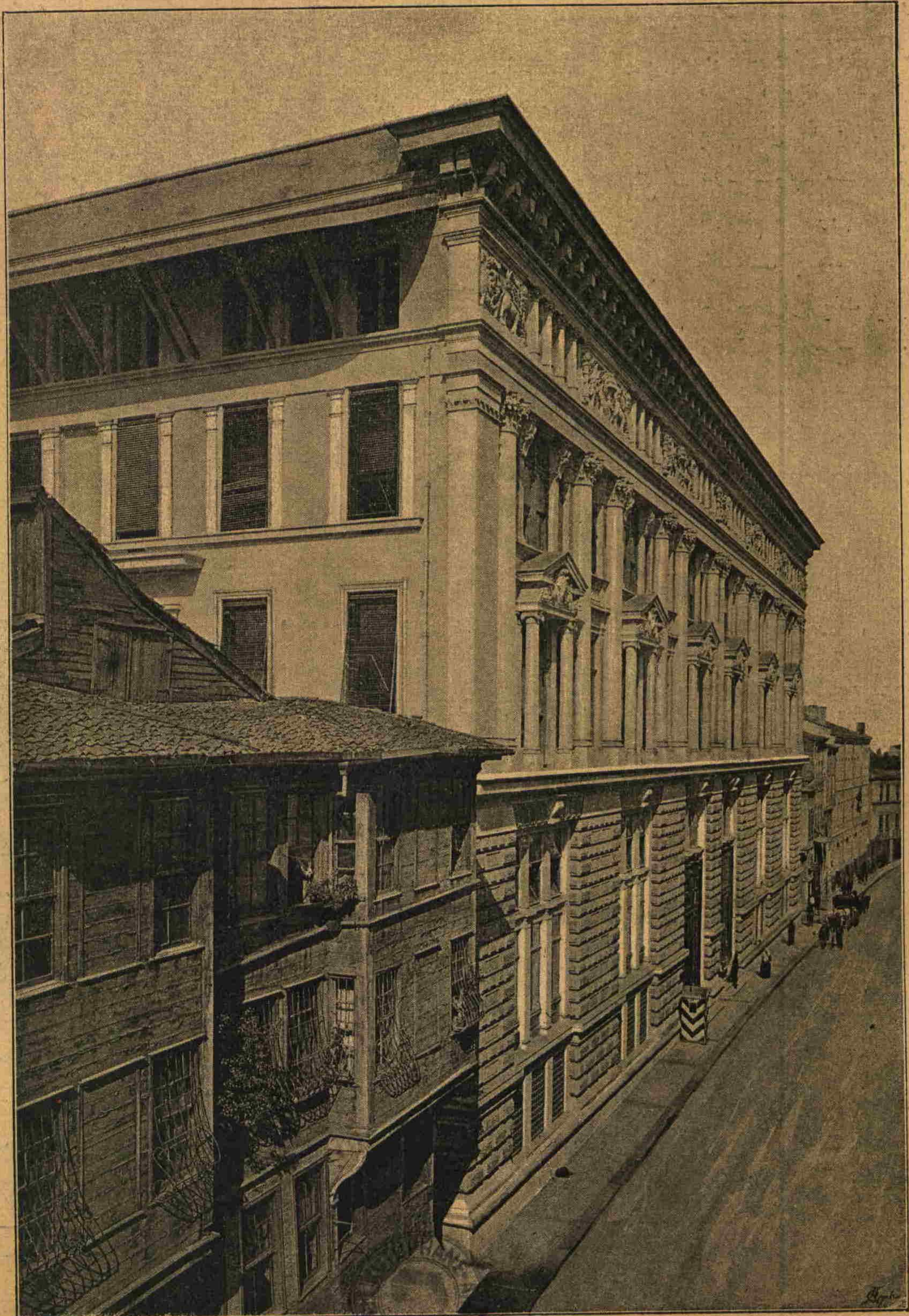
Le Batiment de la Banque I. Ottomane et de la Regie des Tabacs, façade de la rue
